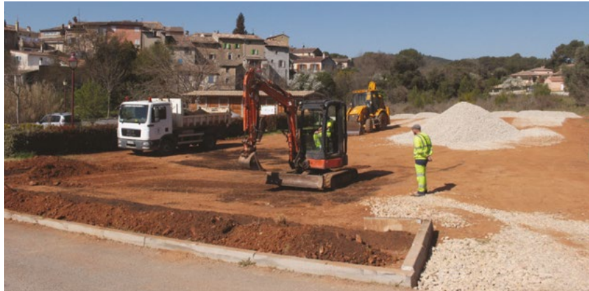
Parking de l'école réalisé en régie par nos agents municipaux
